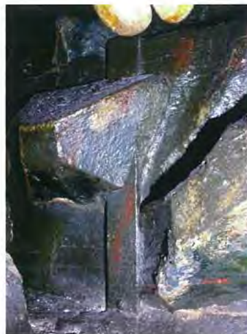
Sur certaines zones, la patte métallique est « prise » dans le bois, ce qui indique qu'elle est originale
