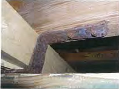
Poutrelle glissée dans une patte en métal forgé
