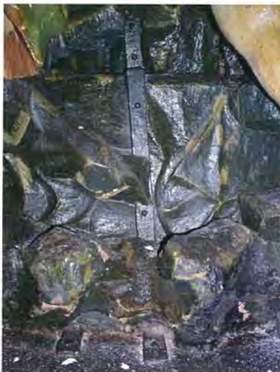
Patte métallique forgée pour épouser la forme du rocher sculpté. Celle-ci fixe par des clous l'élément sculpté au plateau.
