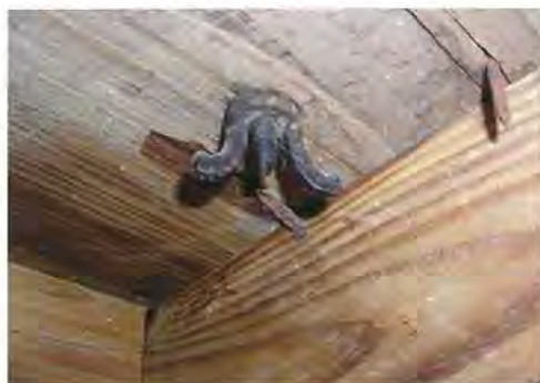
Sous le plateau : Vis et écrou en métal forgé. Les modèles de ces rondelles présentent des différences entre eux, ce qui dénote d'une fabrication à la main, ancienne, peut-être sont-ils originaux.
