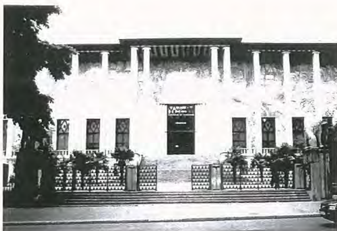
Fig. 40: Façade du M.N.A.A.O.A.
