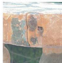
Fig. 117 Oxydation du bois par les clous.
