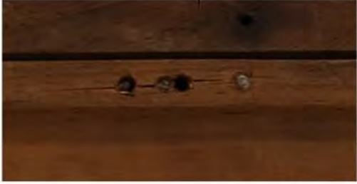
Cinq trous, dont trois parcourus par une fissure
