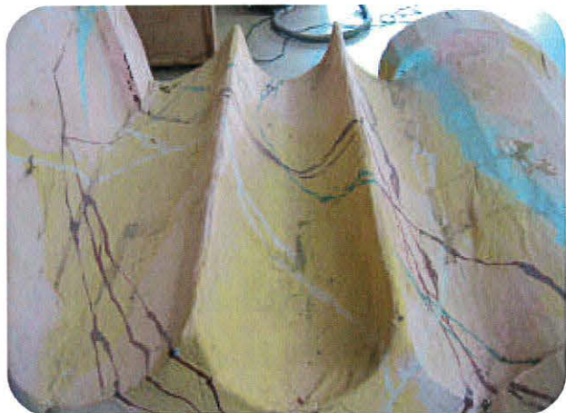
Vue générale de l'état de conservation de l'assise.
