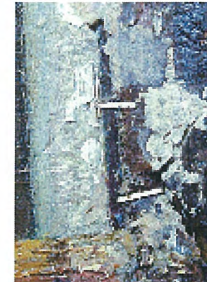
1. Détail de l'accroche par agrafe des lés après retrait du kraft
