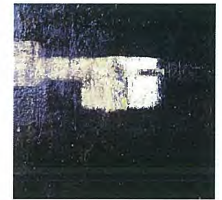
8. Détail des mastics recouvrant la zone de toile dégradée, dans le fût de la colonne en bordure gauche (partie hors champ)
