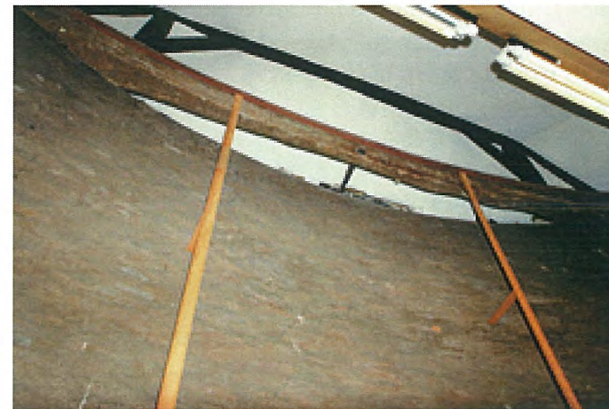
Structure portante après dépose de la toile lors du chantier
