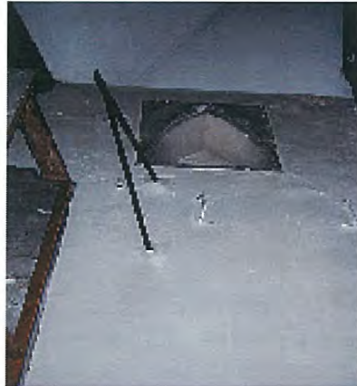
Vue de l'ouverture latérale (à gauche on aperçoit le coffrage)
