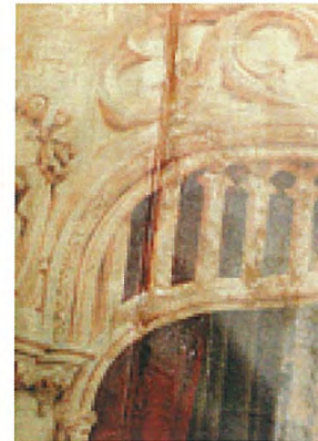
Vue de la bande de kraft peinte dans les tons sur la jonction des lés
