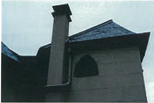
Vue extérieure de l'ouverture latérale fermée par une plaque de zinc
