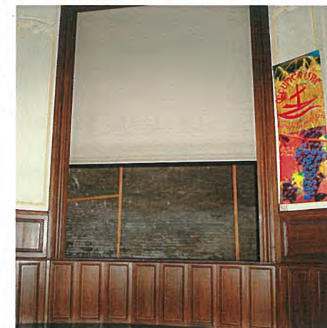
L'ouverture de l'extension fermée par le rideau électrique
