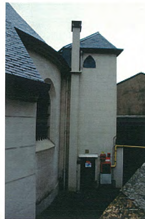
Vue extérieure de l'extension
