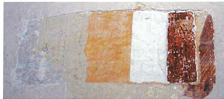
Sondage sur la colonne de la baie de la chapelle
