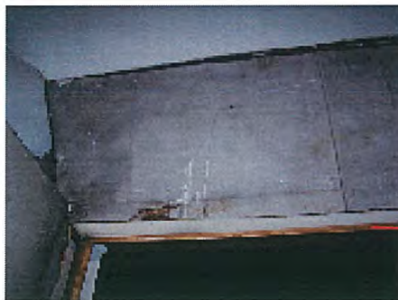
Vue de la partie haute de l'ouverture depuis l'intérieur de l'extension
