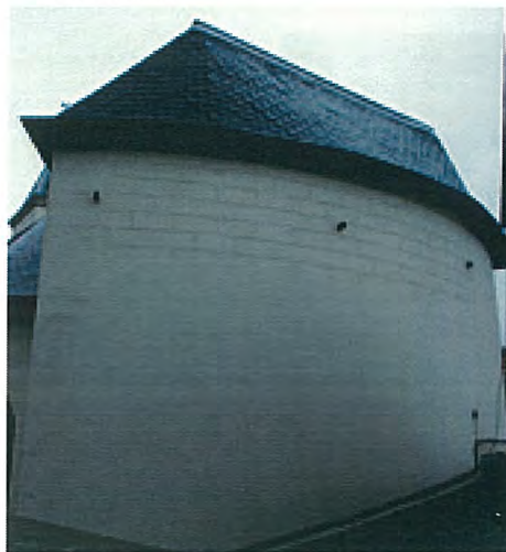
Vue arrière de l'extension du chœur
