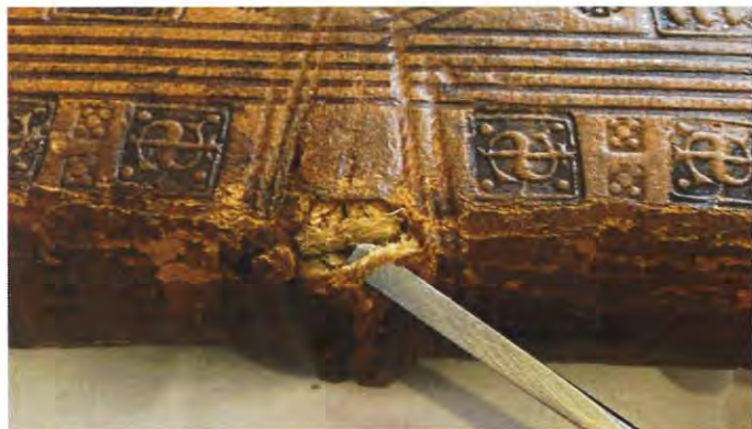
Figure 68 : Extrémité supérieure fendue du double-nerf du milieu.
