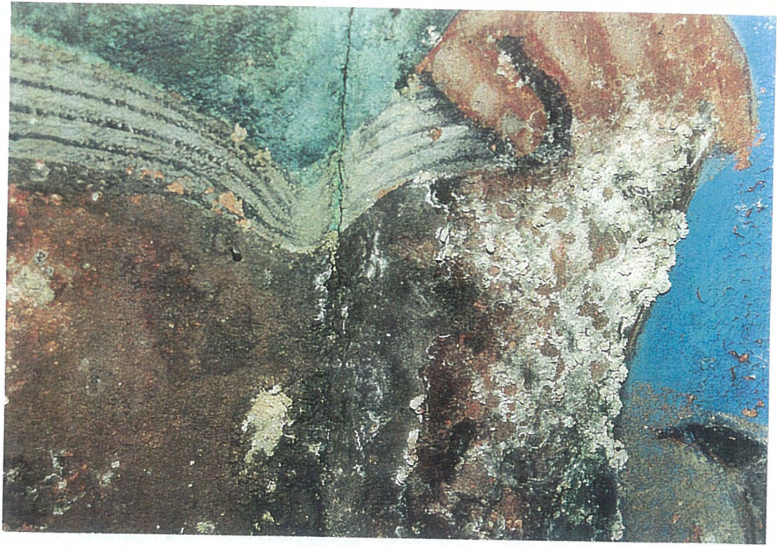
photo 78 : concrétions et efflorescences
