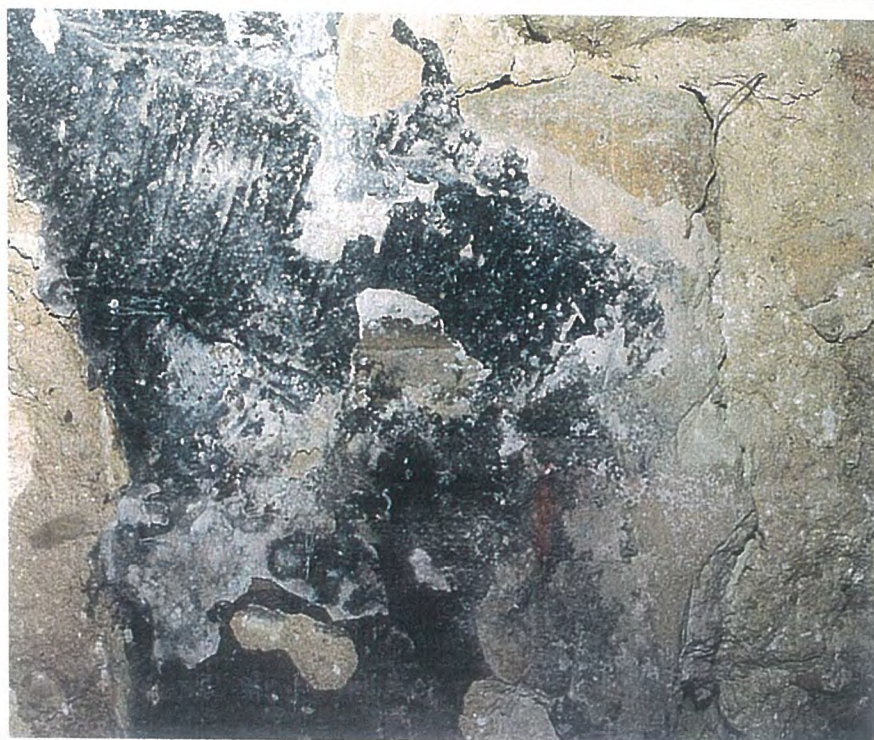
photo 36 : Sondage du mur Nord
