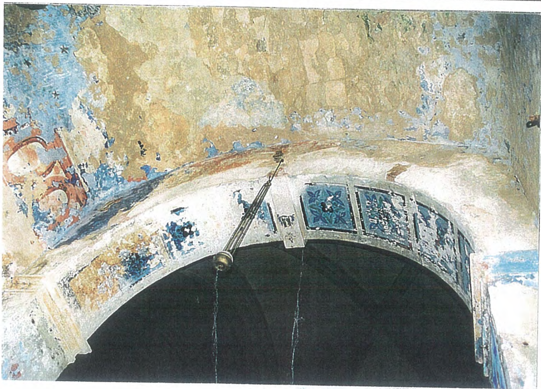
photo 56 : voûte et mur diaphragme
