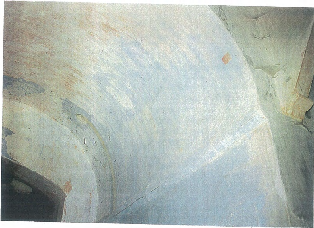
photo 34 : sondage à la voûte du vestibule
