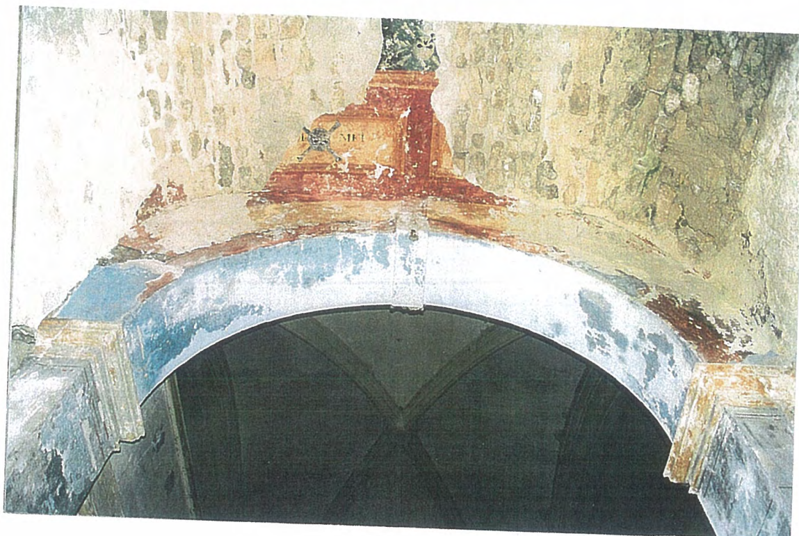
photo 50 : voûte et mur diaphragme
