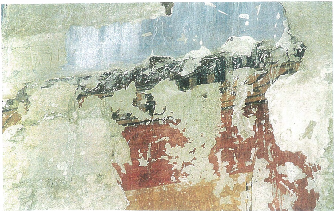
photo 52 : détail du mur Est
