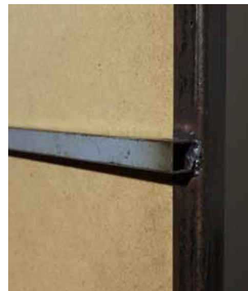
3. Détail de l'assemblage du châssis composé de tubes carrés en métal et du cadre (bords du châssis) composé de cornières d'un autre acier
