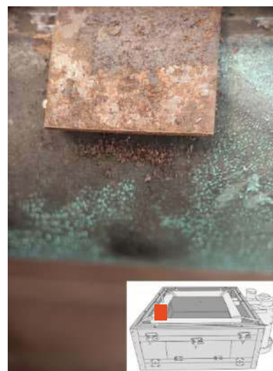
Fig. 90 Détail de la corrosion 4 ©Gabrielle Chailloux
