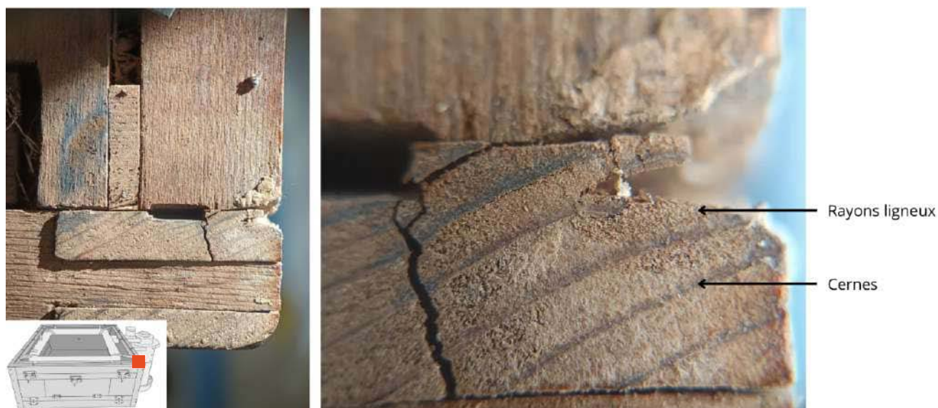
Fig. 5 Détail, vue de la coupe du bois au niveau de la caisse, grossissement x25, 1
