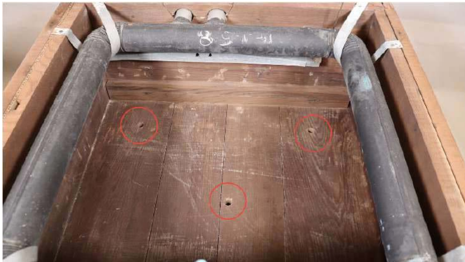
Fig. 15 Détail des ouvertures de ventilation en partie basse ©Gabrielle Chailloux
