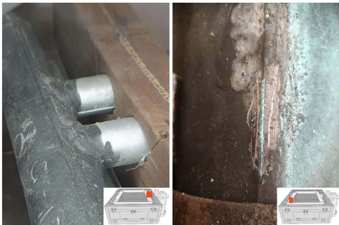
Fig. 34 Détails du revêtement noir et de la couche de galvanisation du réservoir ©Gabrielle Chailloux
