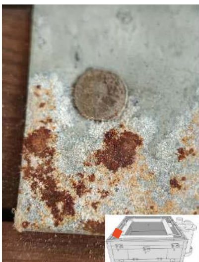
Fig. 89 Détail de la corrosion 3 ©Gabrielle Chailloux
