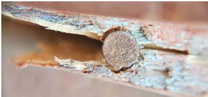
Broquette oxydée sur le patin et feuille ternie de l'écran
