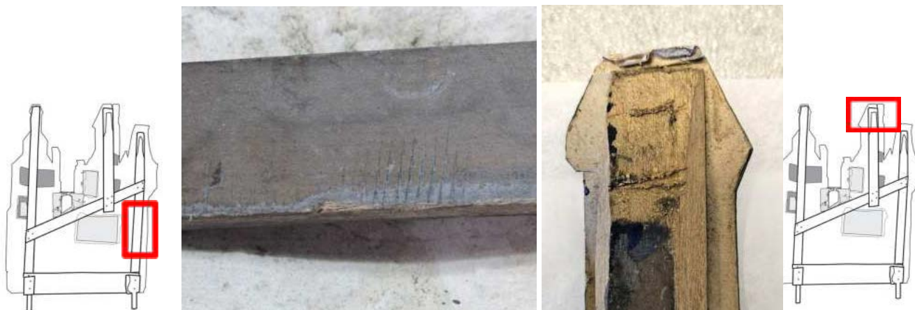
Détails de 31(D) . Traces d'utilisation d'une scie dentelée et de ciseaux à bois
