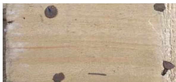
Détail du bois d'un montant de 28(A)
