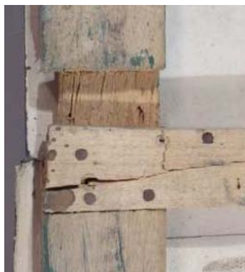
Fissure de la traverse côté sénestre et d'un montant de 28(A)
