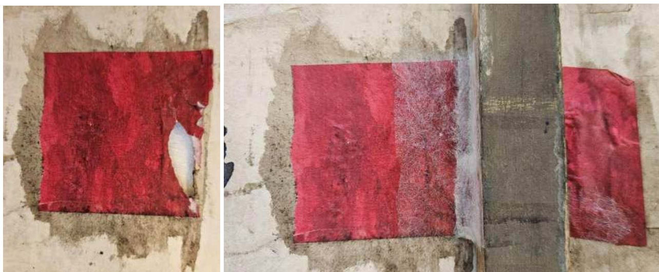
Fenêtre de 31(D) consolidée. L'autre morceau de ce papier est toujours accroché au bâti. Il est repositionné lors du remontage
