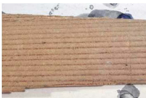
Détail du bois d'un montant de 30(C)
