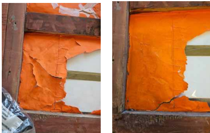
Compartiment de l'écran consolidé face et revers.
