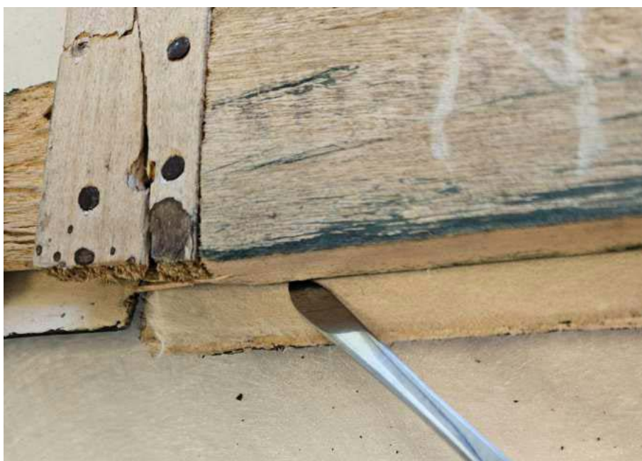
Pli sous le montant dextre de 28(A) en cours de consolidation.
