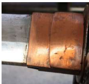
Images 59, 60 : résidus de vernis sur les éléments métalliques dépassant sur la laque adjacente
