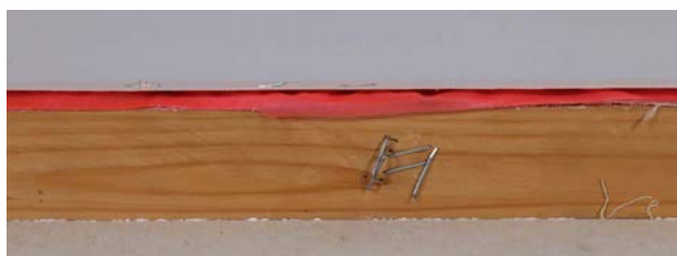
Figure 57. Détail bois résineux châssis. C © N. LEYDER
