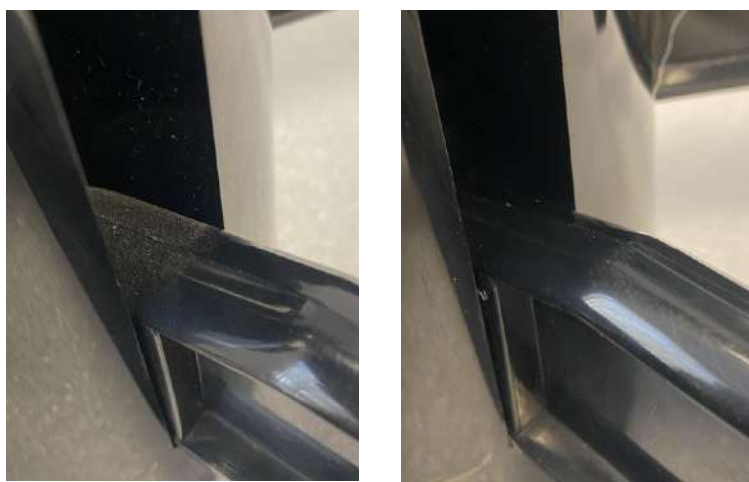
Figure 58 : Détail traitement du dépoussiérage avant/après sur module articulé. ©Z.Pacreau.
