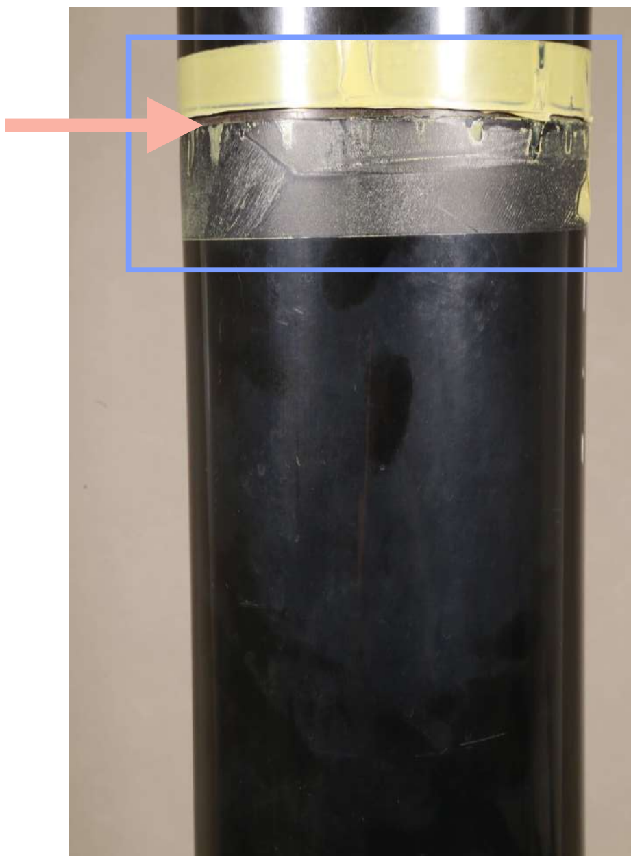
Détail colonne, segment numéro 3.
