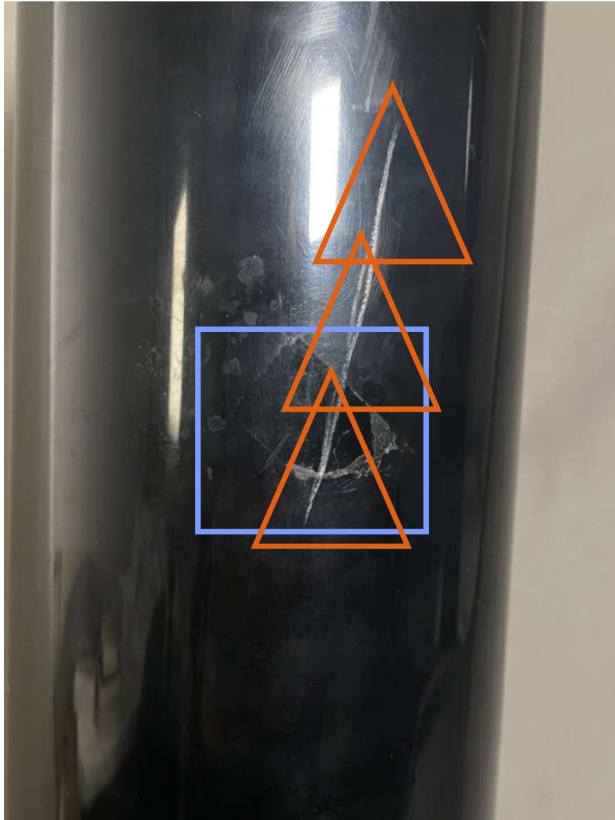
Détail colonne, segment numéro 5.
